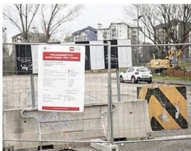
➤ Cantiere in via degli Ulivi
